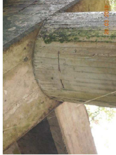
Foto 8. Concreto disgregado com armadura exposta e corroída.
