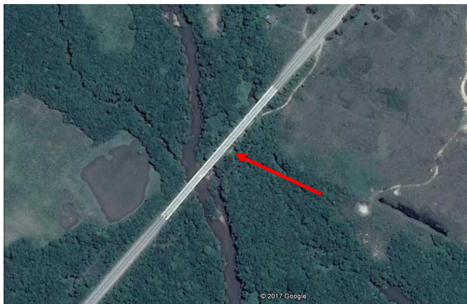
Figura 1: Localização geral da obra (ver seta)
